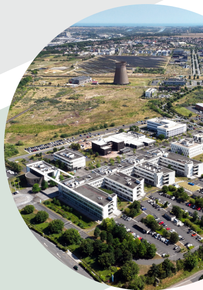
© Septième Ciel Images / Normandie Aménagement
