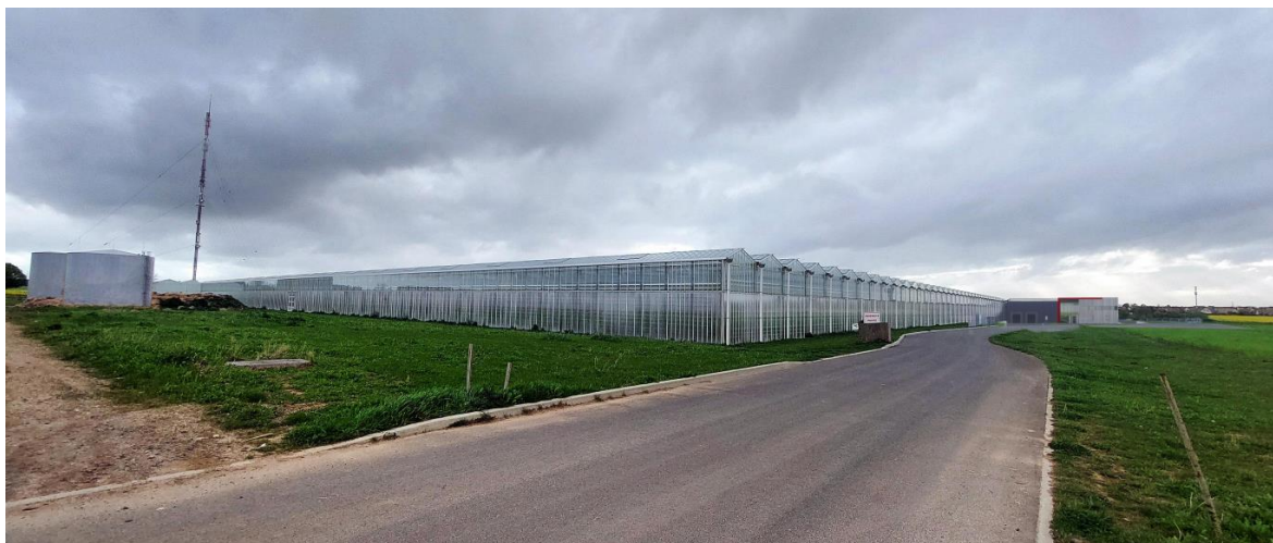
Figure 5.2 : futur site d'ABC 14
